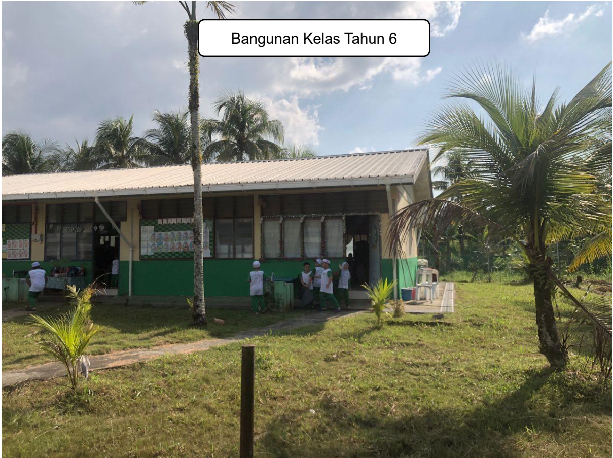
Bangunan Kelas Tahun 6
